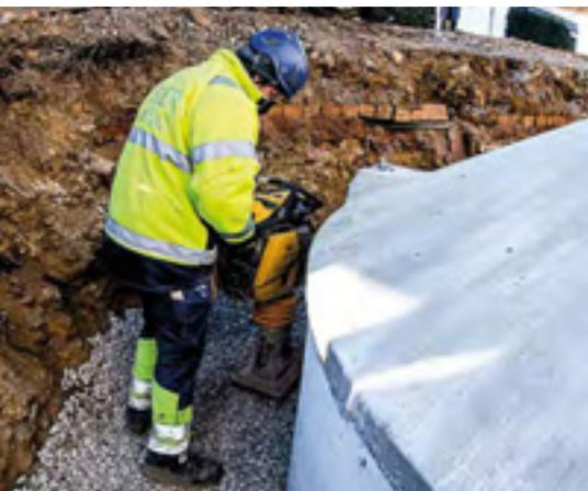
Nach dem Absenken des Speichers in die Baugrube kann unmittelbar mit dem Verfüllen begonnen werden – dafür wird einfach das Aushubmaterial verwendet, das problemlos mit schwerem Gerät verdichtet werden kann (Mall GmbH)
