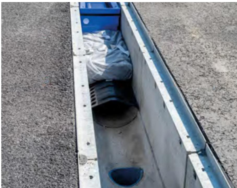
**Getrennte Module:** Die blauen Sedimentationsboxen nehmen zur Grobreinigung alle Feststoffe wie Steine, Laub und Schwebteile auf. Anschließend entziehen die Granulatfilterkissen dem vorgereinigten Niederschlagswasser organische und anorganische Schadstoffe. Das filtrierte und in den freien Abflussraum der Rinne geleitete Regenwasser kann durch Ablaufpunkte in den unterirdischen Rigolen vor Ort versickern.
