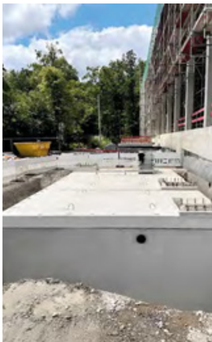
Die modularen Behälter sind mit einem Nutzinhalt von 50 bis 1.000 m³ vielseitig einsetzbar
