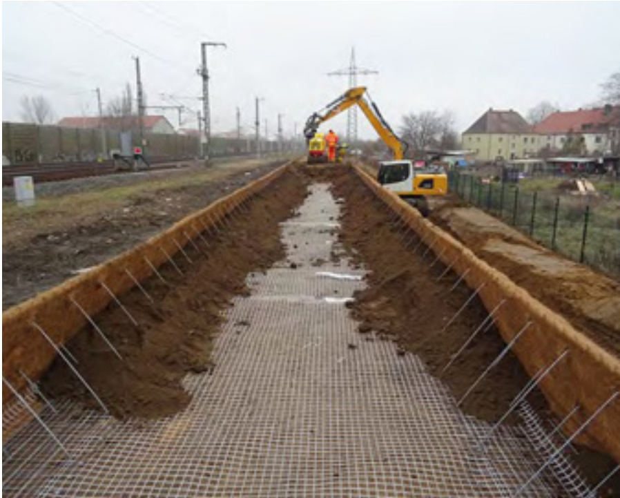
Secumat® GreenLine – biologisch abbaubarer Erosionsschutz im Facing
