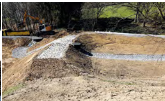
Teilansicht des RBB – Überlauf zwischen dem sanierten Teilbecken und dem neuen nördlich davon gelegenen neu gebauten Teilbecken
