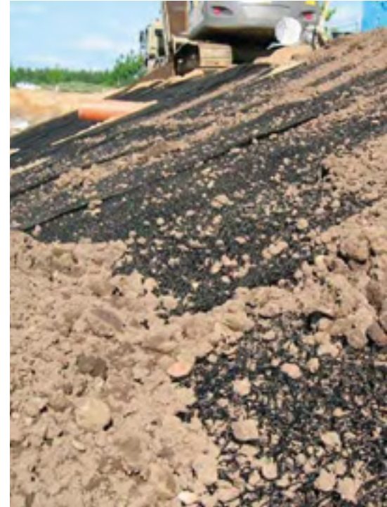
Secumat® ClassicLine – der permanente Erosionsschutz an technischen Gerinnen
