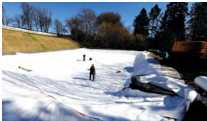
Eingebautes Abdichtungssystem aus TPD und Schutzlagen
