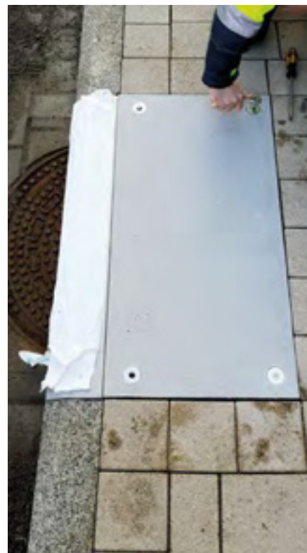
Um an die darunterliegende Abdeckung zu gelangen, werden zunächst die Schrauben der Sonderlösung des Abwasserwerks entfernt (Foto: Abwasserwerk Frankenberg)
