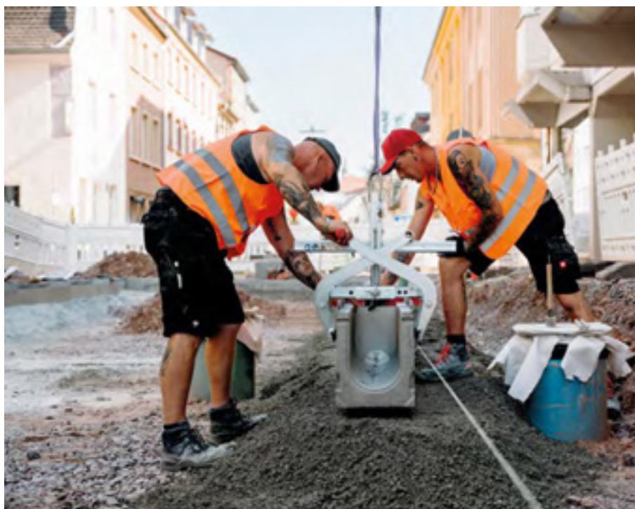
Die Rinnenkörper sind robust und für die zu erwartenden Belastungen ausgelegt
