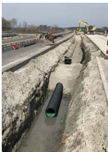
Huckepackanordnung mit AQUATUB-Rw und AQUADRAIN Rohrsystemen
