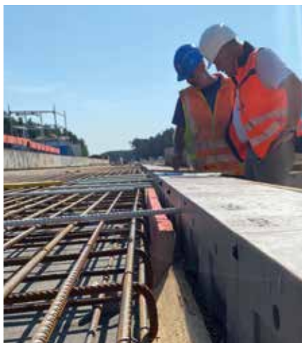
Glasfaser-Verbundstoff-Stäbe zur Verankerung der Hohlbordrinne in der Brückenkappe
