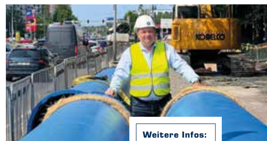
Qualitätsüberprüfung an den angelieferten Rohren
