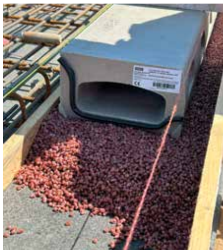
MEAKERB BRIDGE mit durchgängiger Dichtungslippe verhindert Einsickern von Wasser in das Bauwerk
