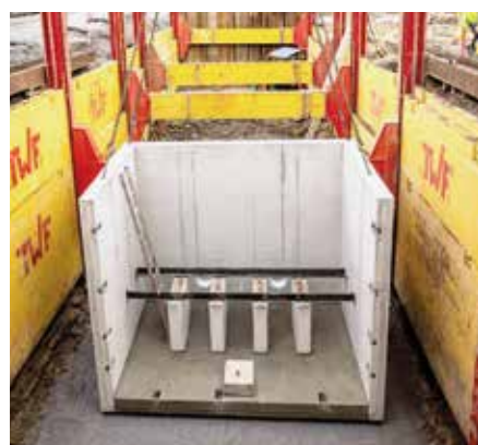
Werkseitig montierte Betonsockel dienen als Pumpenfundamente
