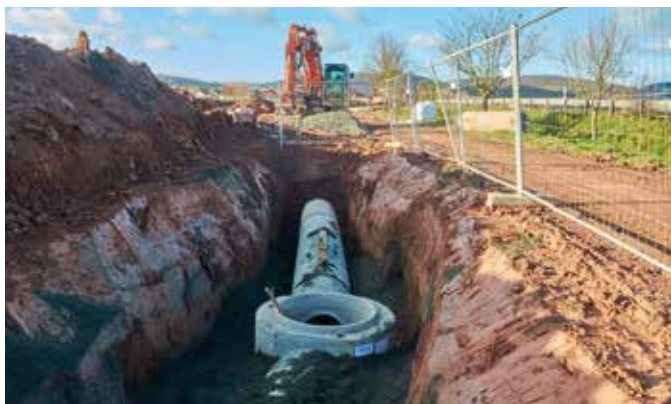
Die Verlegung der Rohre kann sehr einfach und schnell erfolgen (Foto: FINGER BAUSTOFFE GMBH)
