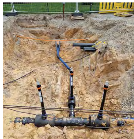
Das neue Schieberkreuz, realisiert mit FRIALOC Absperrarmaturen
