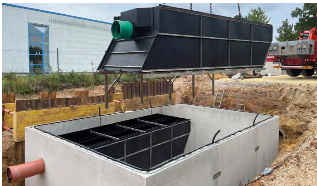
Clevere Regenwasserbehandlung mit dem FUCHS AgilClean – geprüft durch das Prüfinstitut für Abwassertechnik PIA in Aachen
