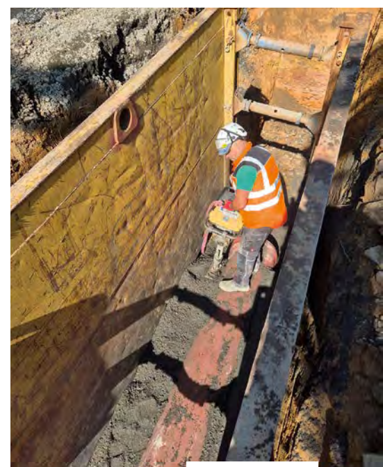
Fachgerechte Verdichtung der Rohrleitungszone Foto: Reuscher Tiefbau GmbH
