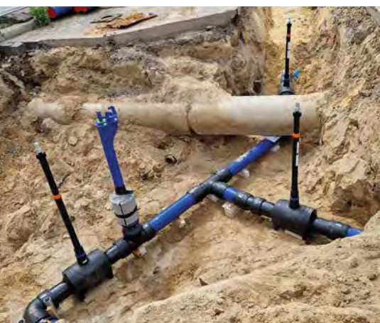
Modernes Rohrleitungsnetzwerk aus Polyethylen
