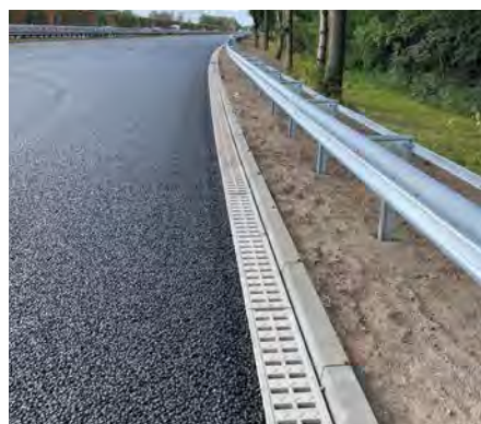
Dank ihrer Länge von nur einem Meter lassen sich die Einzelelemente flexibel auch in radialen Bereichen integrieren
