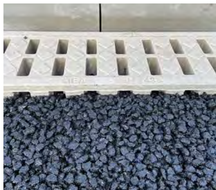
Im Einbau deutlich erkennbar die seitlichen Öffnungen zur seitlichen Entwässerung bei offenporigem Drainasphalt
