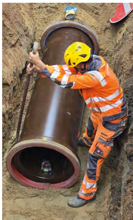
Ausrichten des Rohres mit Laser
