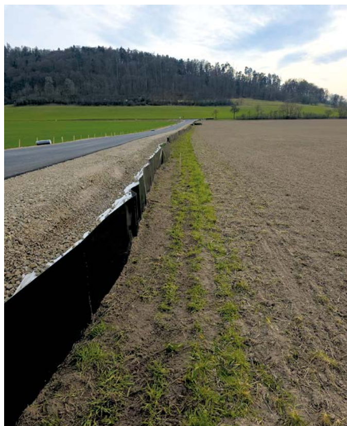
Die flexible Barriere lässt sich effizient über große Entfernungen verlegen
