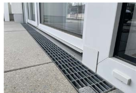
Niveaugleicher Übergang und zuverlässige Entwässerung im Terrassenbereich
