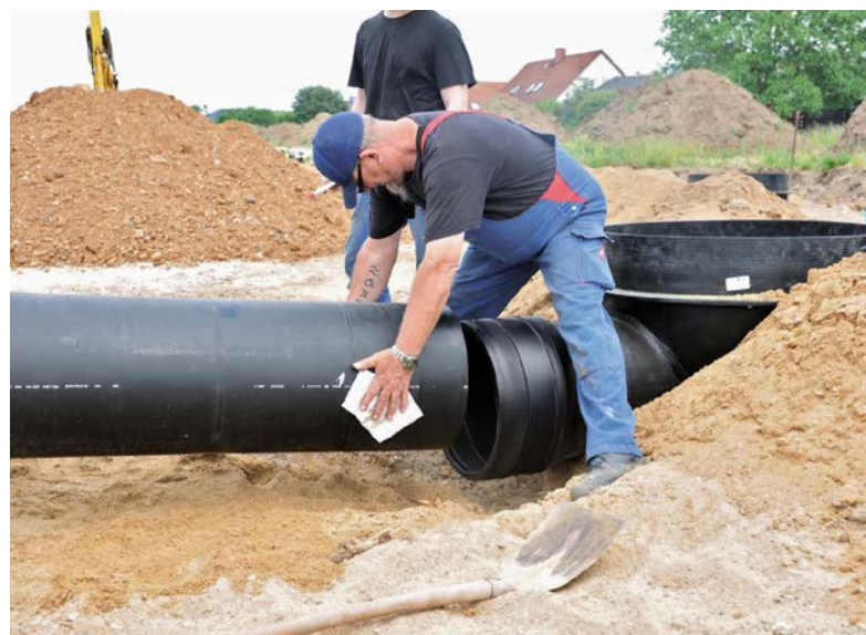
Baustellensichere Montage: PE-Rohrverbindung mit Elektroschweißmuffe
