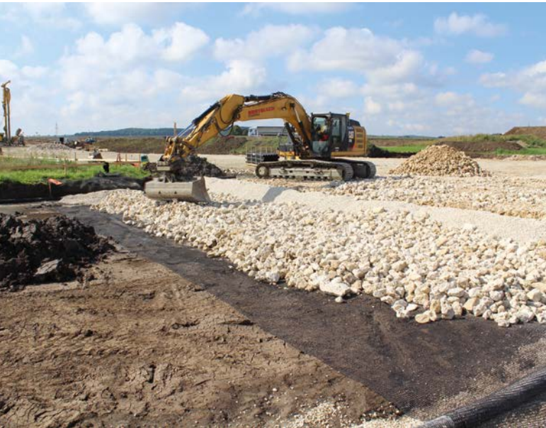
MIRAGRID Geogitter und Geoverbundstoffe sind die idealen Bodenbewehrungsprodukte für Tragschichtbewehrung und Baugrundstabilisierung
