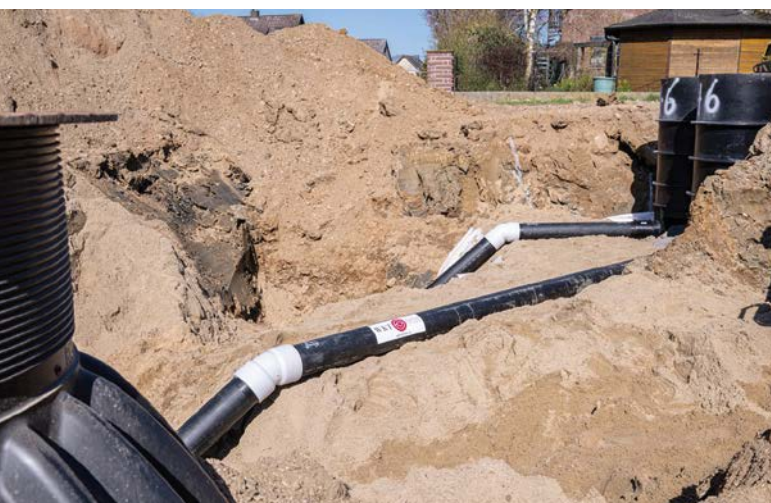
Sicher verschweißte Leitungsführung zwischen zwei Schächten
