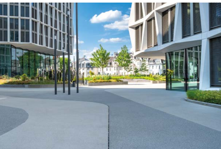
Moderne Gestaltung des Kanzlerplatzes mit ACO Inotec Schlitzrinnen
