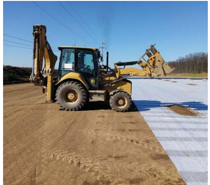
MIRAGRID Geogitter und Geoverbundstoffe sind die idealen Bodenbewehrungsprodukte für Tragschichtbewehrung und Baugrundstabilisierung
