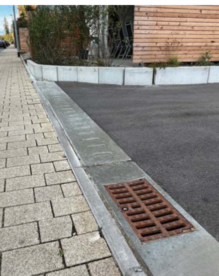
Die Area Drain als leistungsstarke Entwässerungsrinne von großen, versiegelten Flächen wie beispielsweise Parkplätzen
