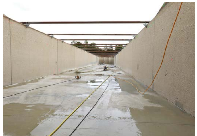
Frisch betonierte neue Betonsole
